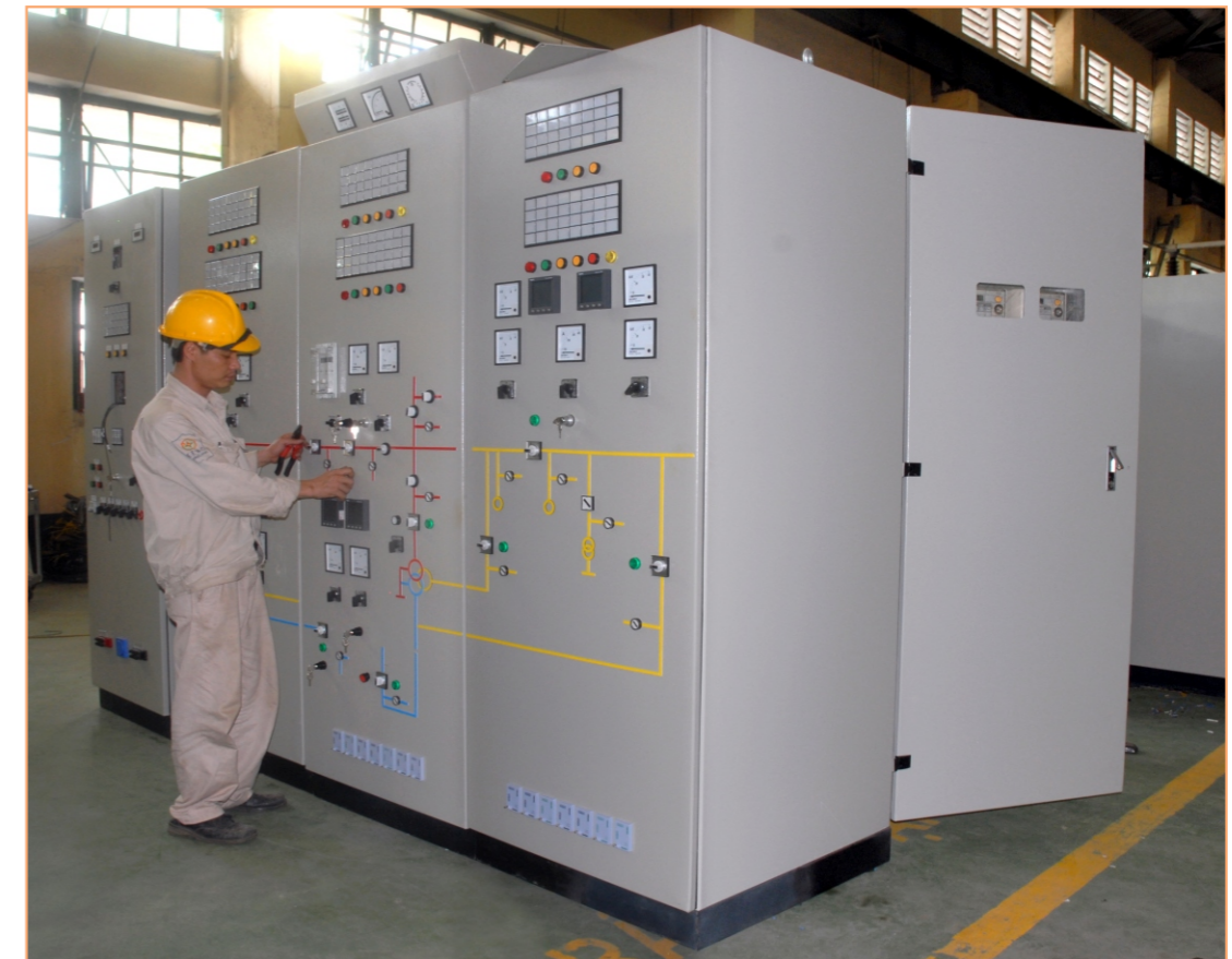
Kiểm tra các chức năng của tủ Checking cubicle functions
