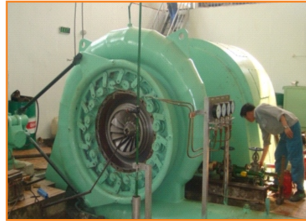
Lắp đặt tua bin thủy điện Đa Khai, Lâm Đồng Installation of turbine at Dakhai HPP, Lam Dong province
