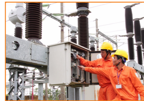
Kiểm tra máy cắt tại trạm Checking circuit breaker at site
