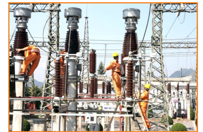
Lắp ráp thiết bị tại trạm Assembling equipment at site
